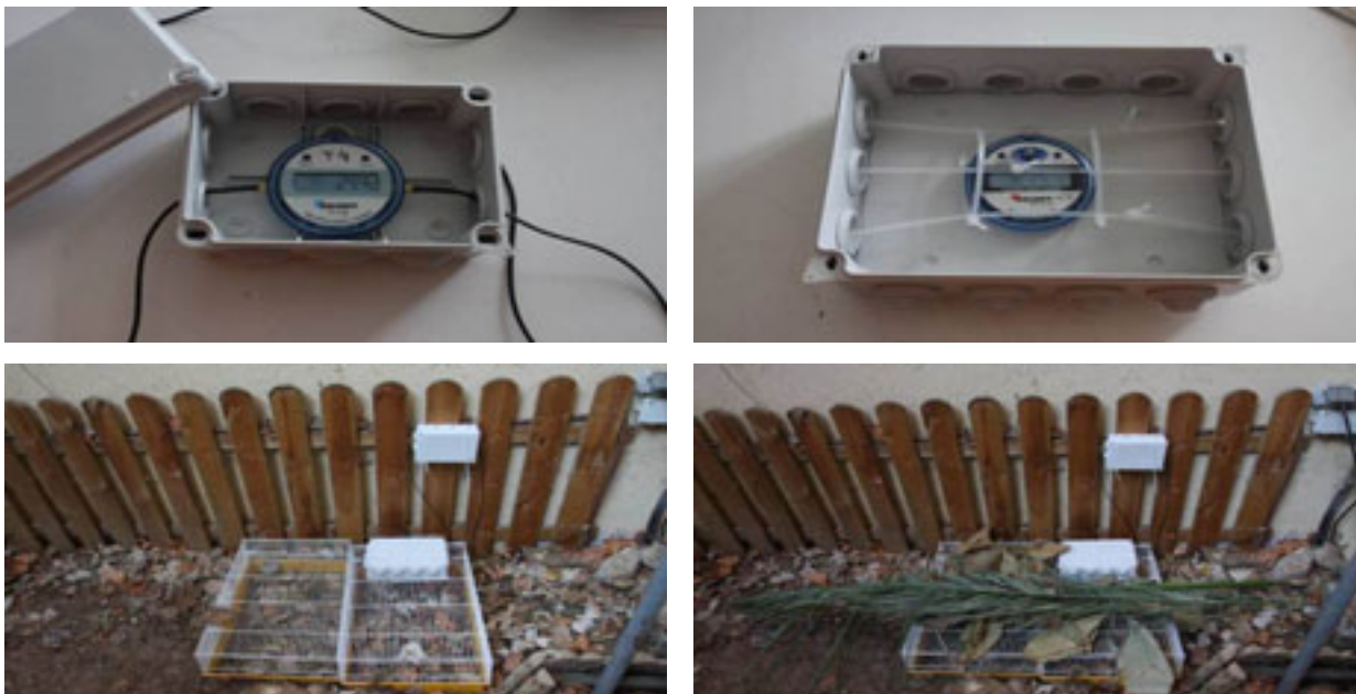
Figura 11. Detall dels enregistradors Escort iLog T4 i H4 (a dalt, d'esquerra a dreta, respectivament). A baix, la instal·lació dels dos sensors; el T4 penjat a la paret i l'H4 a sobre les caixes, ambdós enregistradors protegits de la intempèrie per caixes estanques. A la dreta les caixes cobertes amb fulles, amb funció tèrmica i visual.
