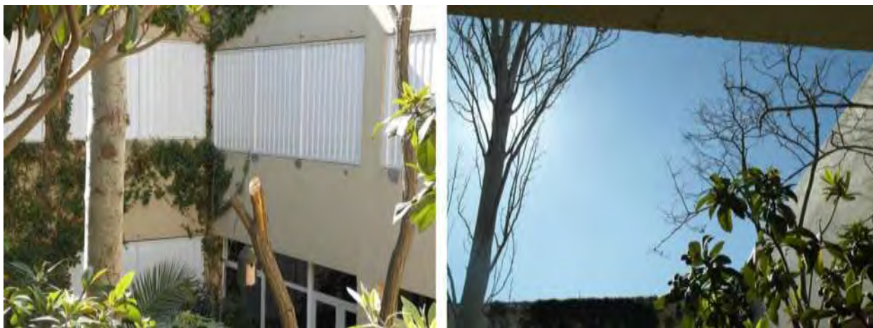
Figura 10. Detall de la robínia que se li va treure la capçada (esquerra) i de l'espai d'entrada de llum que s'ha guanyat
