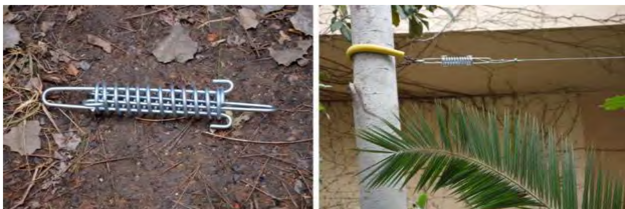
Figura 6. Detall del tipus d'amortidors utilitzats (esquerra) i de la seva situació entre la cadena amb protector de goma de l'arbre i el cable (dreta).
