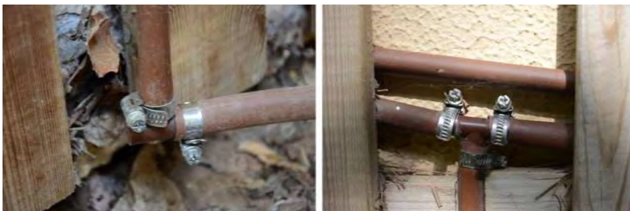
Figura 14. Detall del reforçament de les connexions "L" (esquerra) i "T" (dreta) amb abraçadores metàl·liques. Aquest reforçament es va dur a terme, per seguretat, amb totes les connexions del reg gota a gota.
