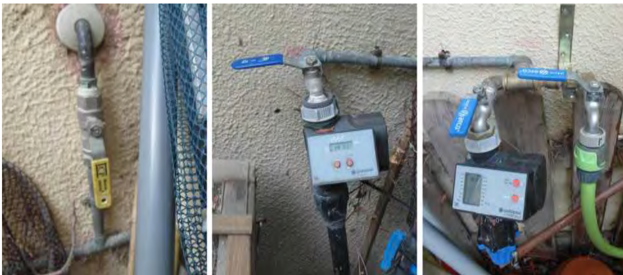
Figura 13. D'esquerra a dreta, la clau de pas general, la dels aspersors, la del reg gota a gota i la de la mànega.
